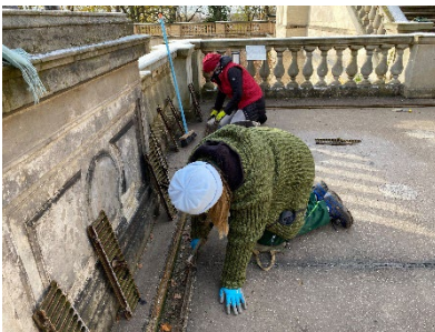
Regenrinnen werden gereinigt, © SPSG/FVP, Foto: Michael Lüder
