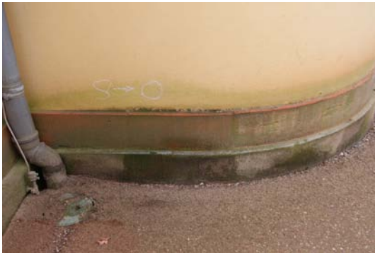
Grünspan an den Außenwänden Pomonatempel (c) SPSP, FVP
