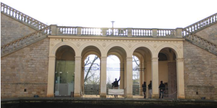
Die Eingangshalle des Belvedere vom Innenhof aus betrachtet © SPSG, Foto: Förderverein Pfingstberg
