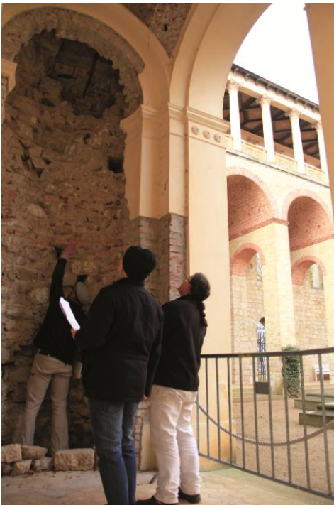
Baubegleitung am Belvedere © SPSG, Foto: Förderverein Pfingstberg
